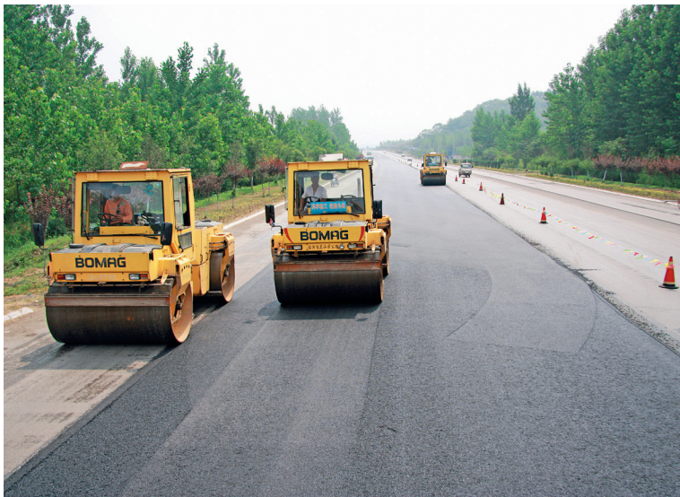
道路修补施工现场
