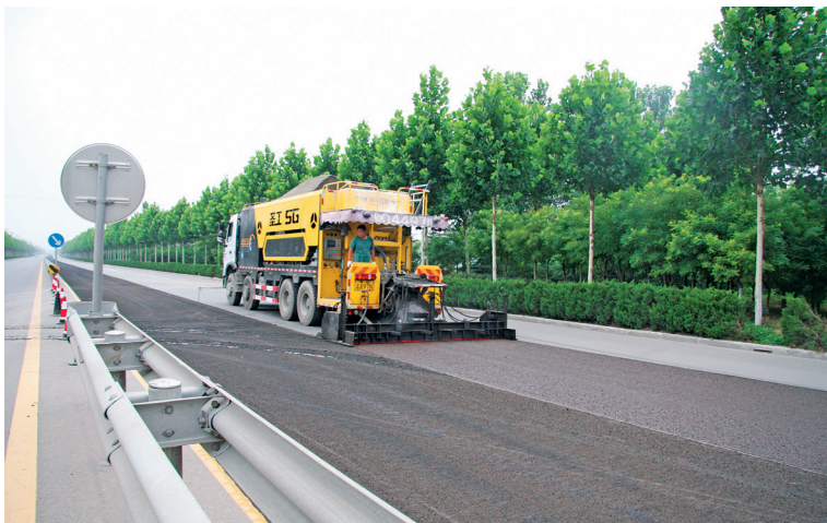
沂蒙路北延快速通道建设现场
