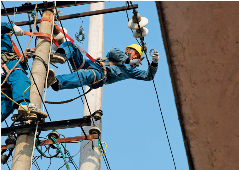
在汪沟镇大柳汪村开展低压线路改造
