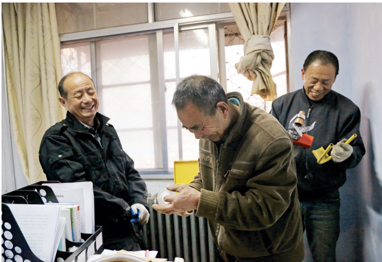
工作人员维修暖气管道
